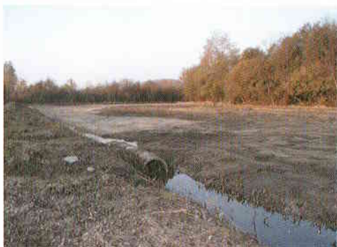
Intervento di asportazione dello strato superficiale del terreno - foto di Daniele De Luca.
