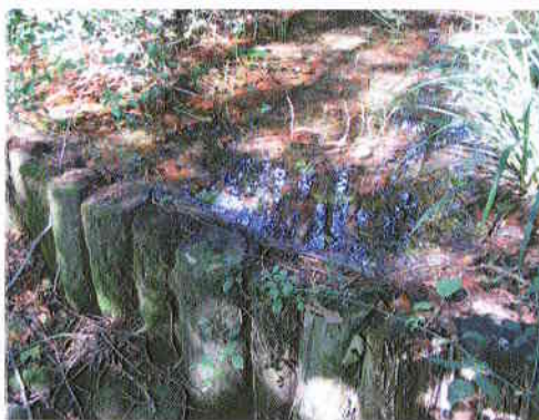
Soglia in legno per controllo livello di magra - foto di Carlo Blason.
